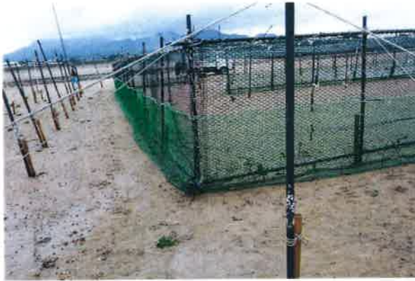
5/29 ポリ有結ネット取り付け後の施設
