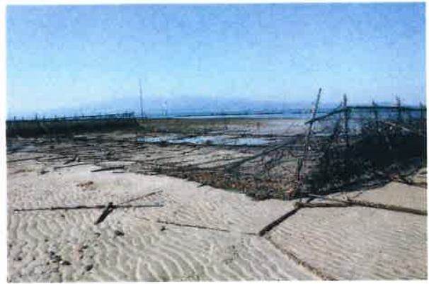
9/30 台風24号通過の影響で損壊した施設
